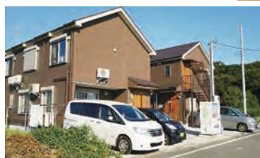
手前の建物がともに一ホーム本体、 隣の建物1階がスマイルともに一、 2階はともに一ホーム2
